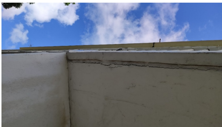
Image 1 : exemple de fissuration (bâtiment A – hall, photographie A. Delcroix, 26 août 2022)
